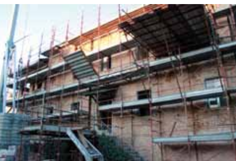
I lavori di ristrutturazione della canonica
