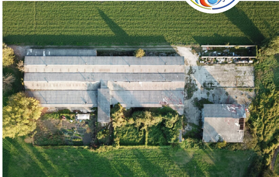
Foto: L'ecomostro di via Molza a Sant'Anna con il suo carico di amianto
