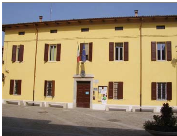
Completamente ristrutturata anche la facciata del palazzo comunale nel lato di Corso Libertà, che ospita la sede della Polizia Municipale
