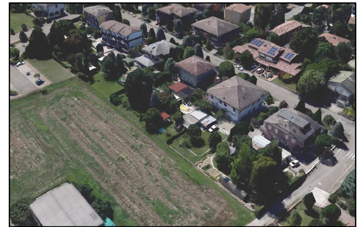
Ripresa fotografica dello stato di fatto
