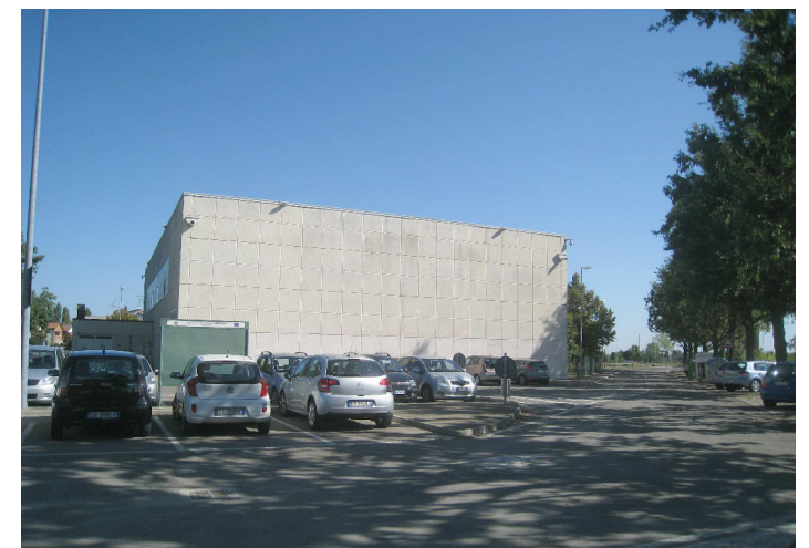
Ripresa fotografica dello stato di fatto
