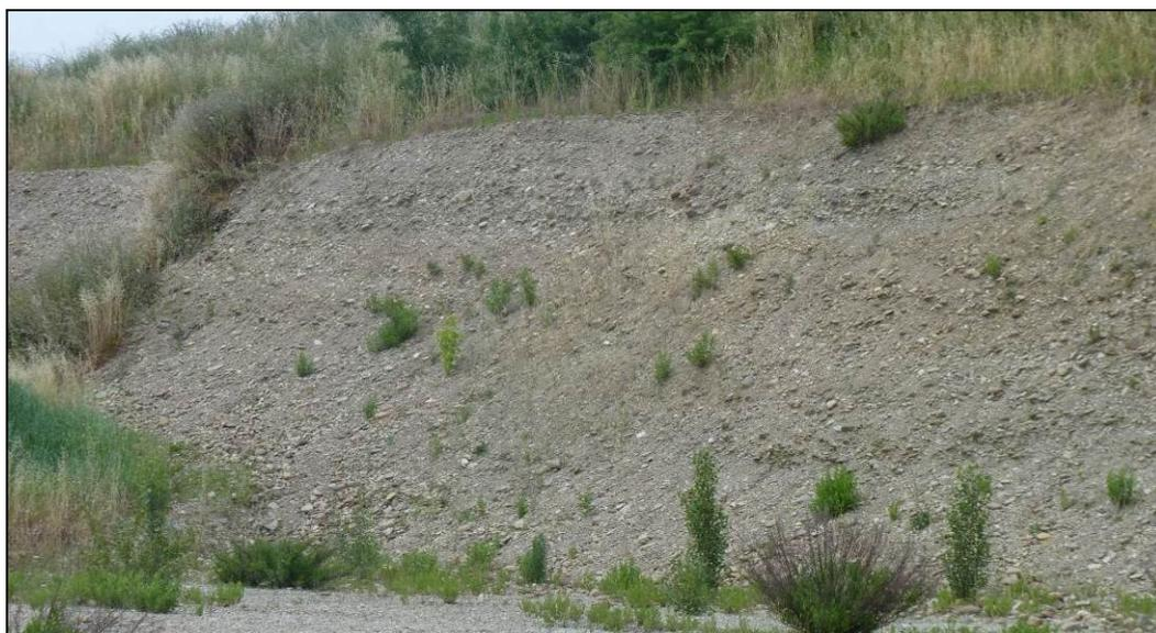
*Figura 6: Vista del fronte di scavo attivo in direzione ovest; la profondità dello strato ghiaioso si attesta a circa – 1,7 m di profondità del piano campana originario.*
