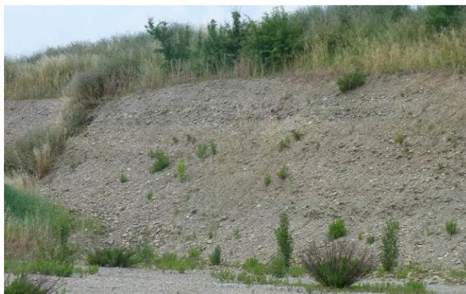
Figura 3: Vista del fronte di scavo attivo in direzione ovest; la profondità dello strato ghiaioso si attesta a circa - 1, 7 m di profondità del piano campagna originario.
