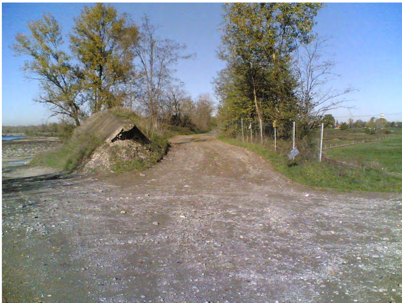
FOTO 2: Veduta della strada di servizio al guado fluviale esistente.
