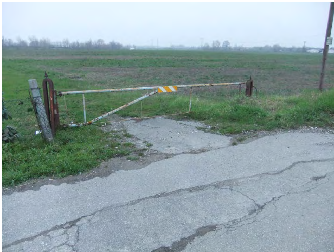
FOTO 12: Veduta dell'accesso carraio esistente sulla Strada Provinciale di Castelfranco.
