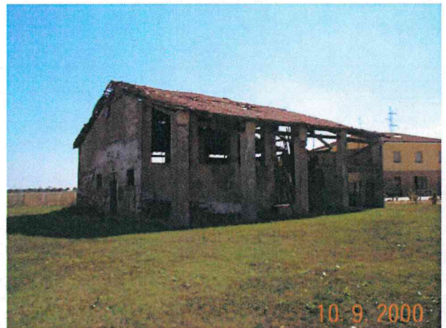
Edificio C/D vista da nord ovest
