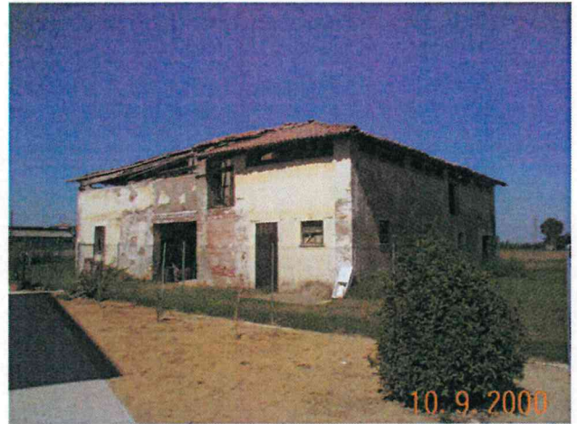
Edificio C/D vista da sud
