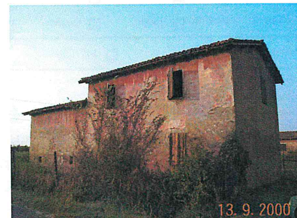
Edificio A vista da sud est
