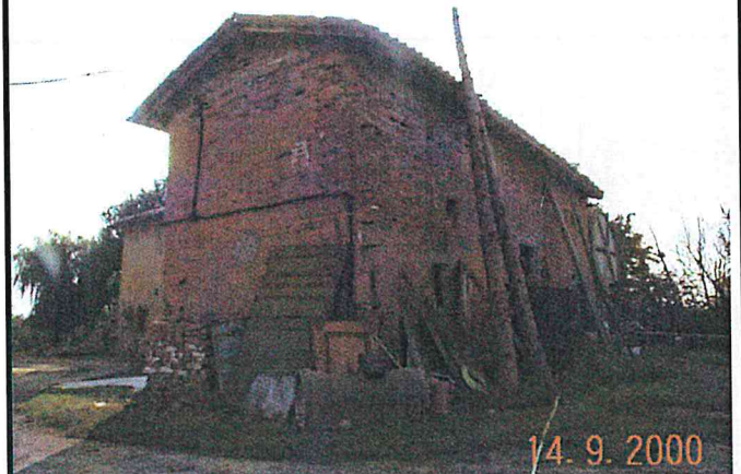
Edificio F vista da nord est
