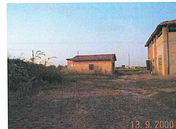
Edificio F vista da sud
