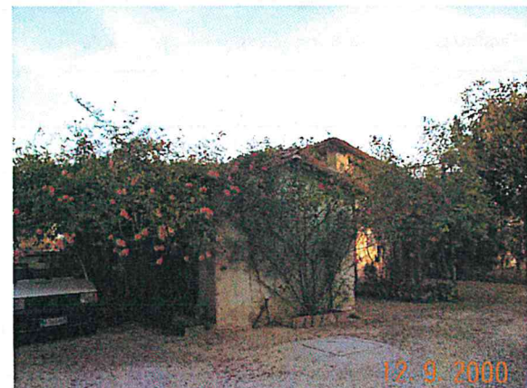
Edificio F vista da nord ovest
