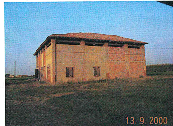
Edificio B vista da sud
