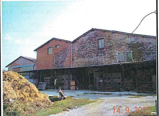
Edificio C/D vista da nord
