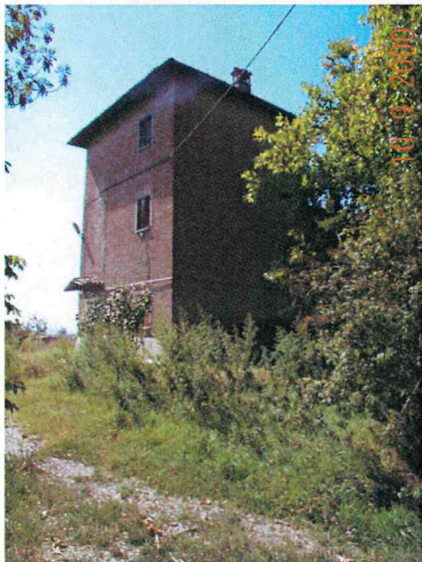
Edificio A vista da nord est
