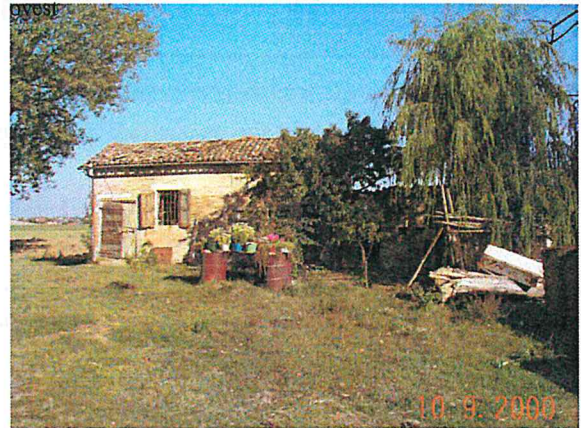
Edificio F vista da est
