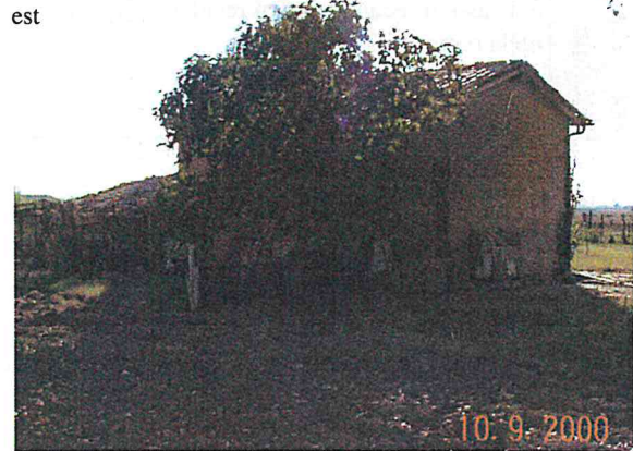
Edificio F vista da nord est
