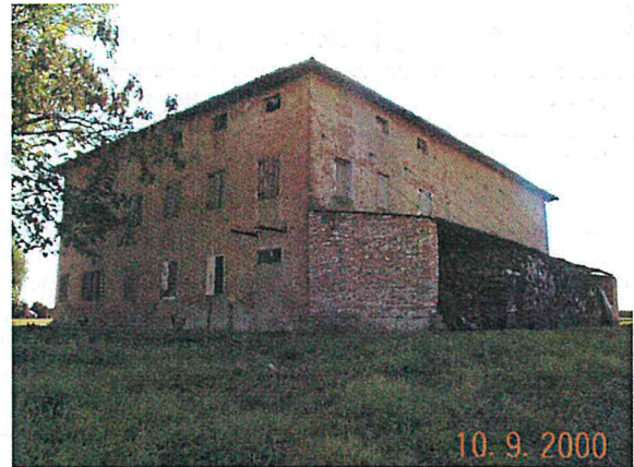
Edificio Ae C/D vista da nord est
