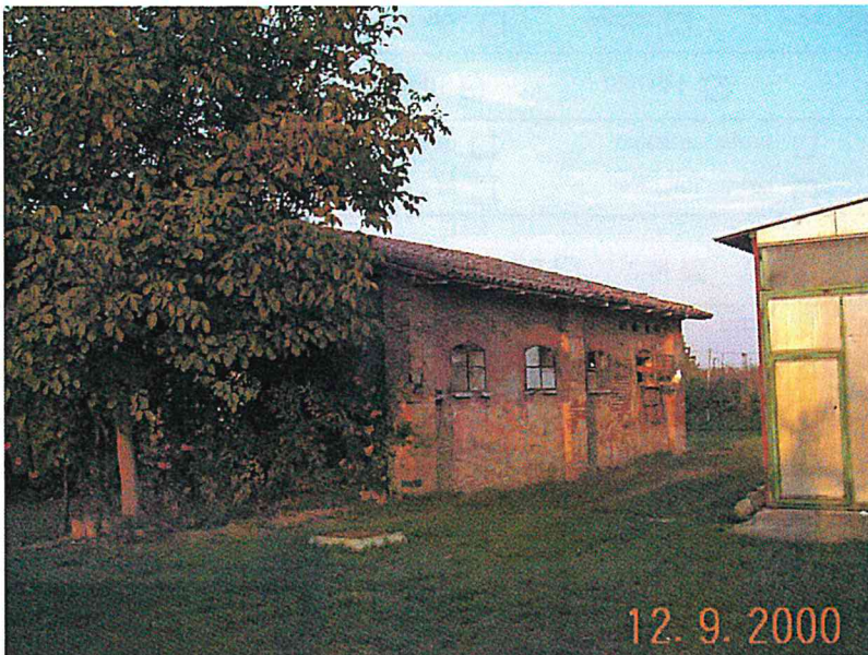
Edificio F vista da ovest
