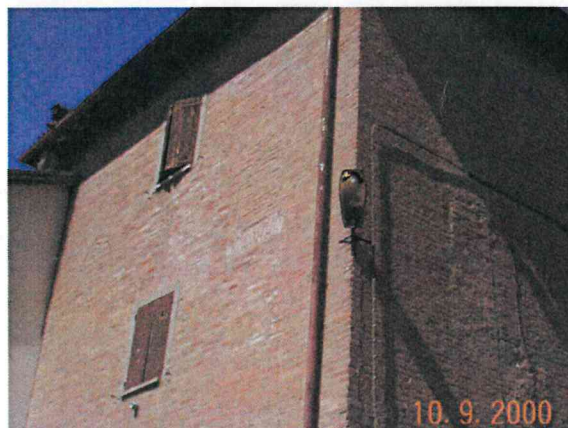
Edificio A vista da sud est
