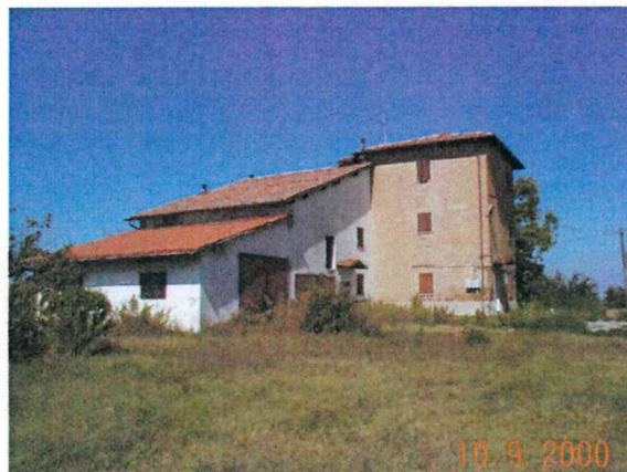
Edificio A vista da sud ovest
