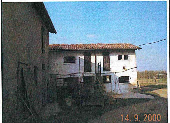
Edificio F vista da sud
