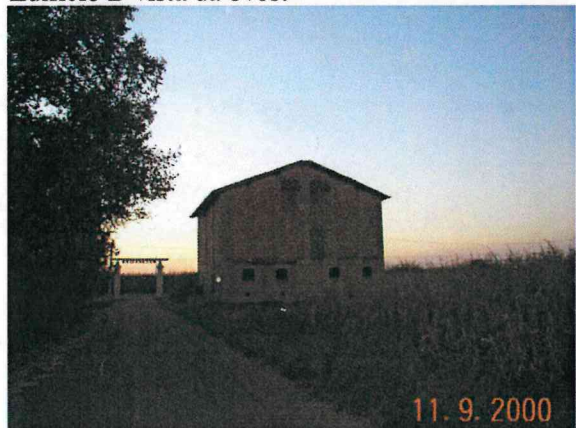
Edificio C/D vista da est
