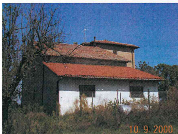
Edificio A vista da nord est
