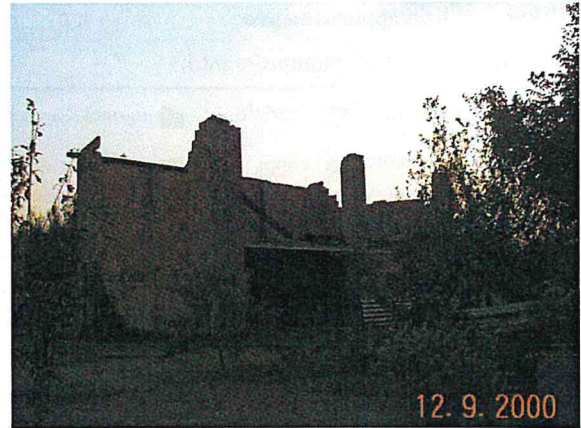
Edificio B vista da nord
