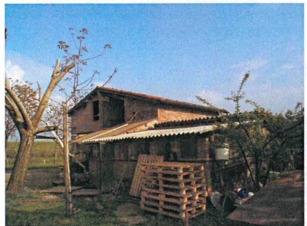
Edificio F vista da sud ovest
