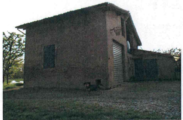
Edificio F vista da est
