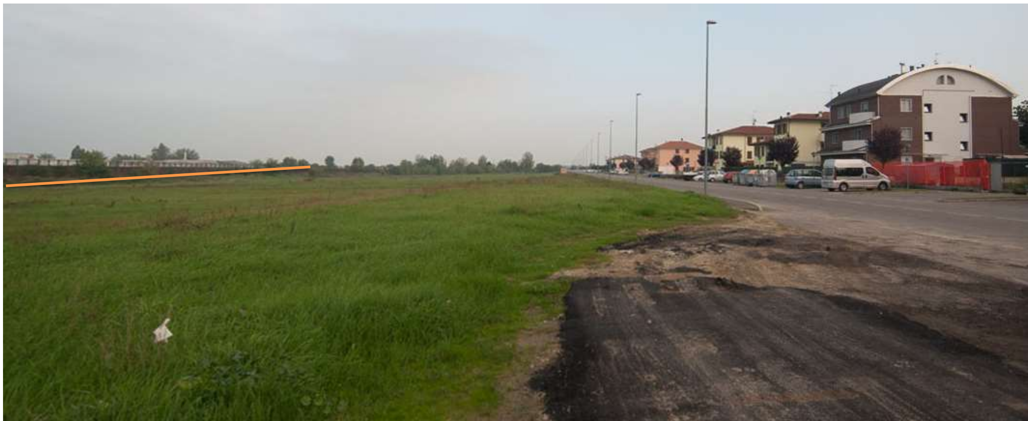
FOTO 12. Viabilità al piede dell'autostrada
