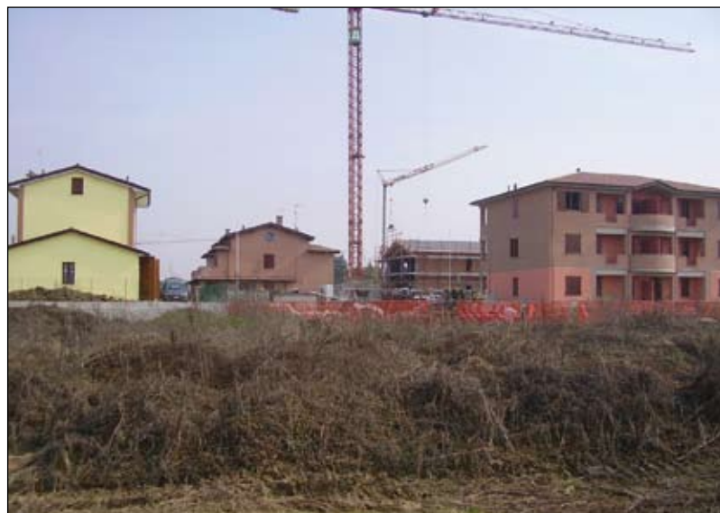
Le nuove palazzine, alcune già abitate, altre in fase di completamento, realizzate per le famiglie delocalizzate da via Don Monari
