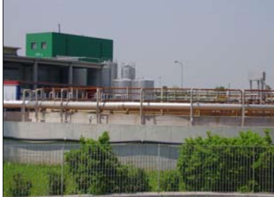
La vasca di bilanciamento dello stabilimento Far.Pro di Spilamberto
