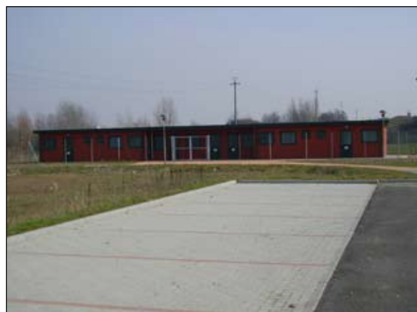
L'esterno e l'interno dei nuovi spogliatoi del campo sportivo con il parcheggio adiacente
